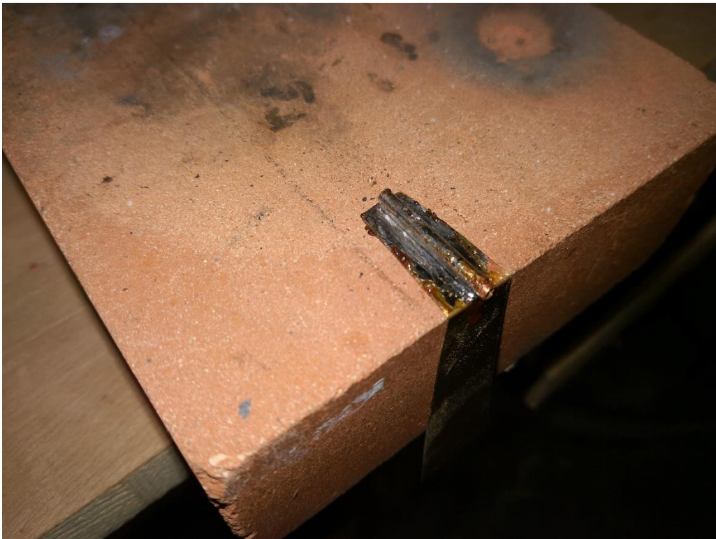
84: Weichlot hält in der Regel den Belastungen stand, abschließend verputzen.
