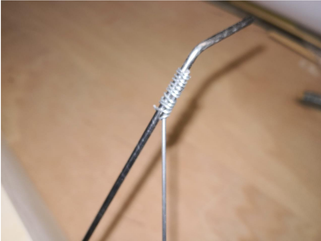
79: Eine saubere Wicklung von Bindendraht, der vorher angeschliffen wurde, um die Verzinkung zu entfernen.
